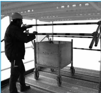
La recette peut être approvisionnée par lift ou chariot élévateur. L'opérateur accède de façon sécurisée aux matériels livrés.
