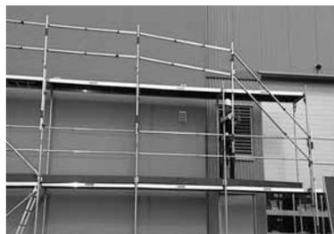
Deux types d'élément : le montant à poignée de déverrouillage et la lisse aluminium extensible en deux dimensions. La poignée de déverrouillage, actionnée en partie basse ou haute du montant, permet de desserrer les deux mâchoires et de monter ou descendre la protection d'un niveau, les lisses étant emboîtées sur les ergots à bascule du montant.
