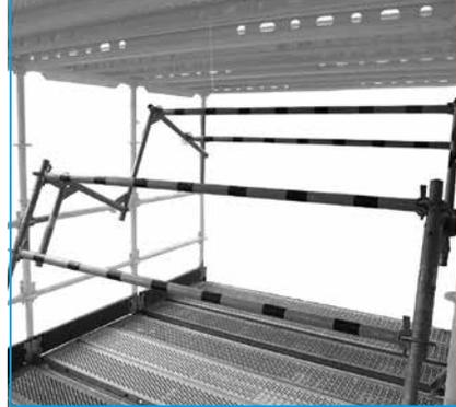
En basculant pour permettre l'approvisionnement de la recette, l'opérateur se retrouve protégé par un nouveau garde-corps l'isolant de la zone à risque.
