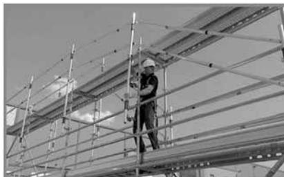
Deux types d'élément : le montant à poignée de déverrouillage et la lisse aluminium extensible en deux dimensions. La poignée de déverrouillage, actionnée en partie basse ou haute du montant, permet de desserrer les deux mâchoires et de monter ou descendre la protection d'un niveau, les lisses étant emboîtées sur les ergots à bascule du montant.
