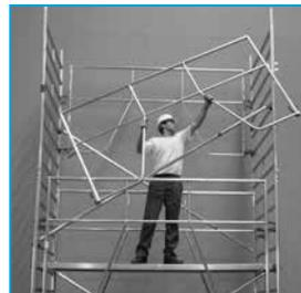
**Le garde-corps de sécurité est mis en place par un seul monteur, d'un côté, puis de l'autre.**
